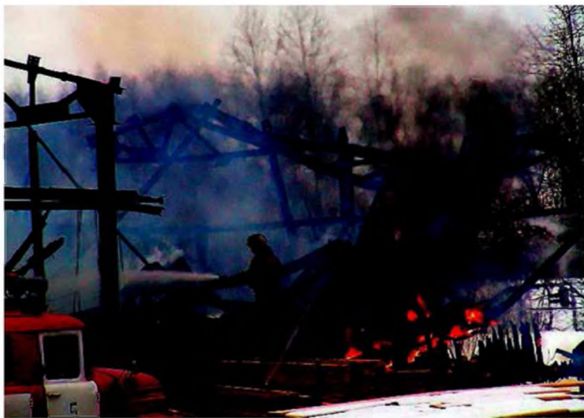
Тушение пожара. Фото
